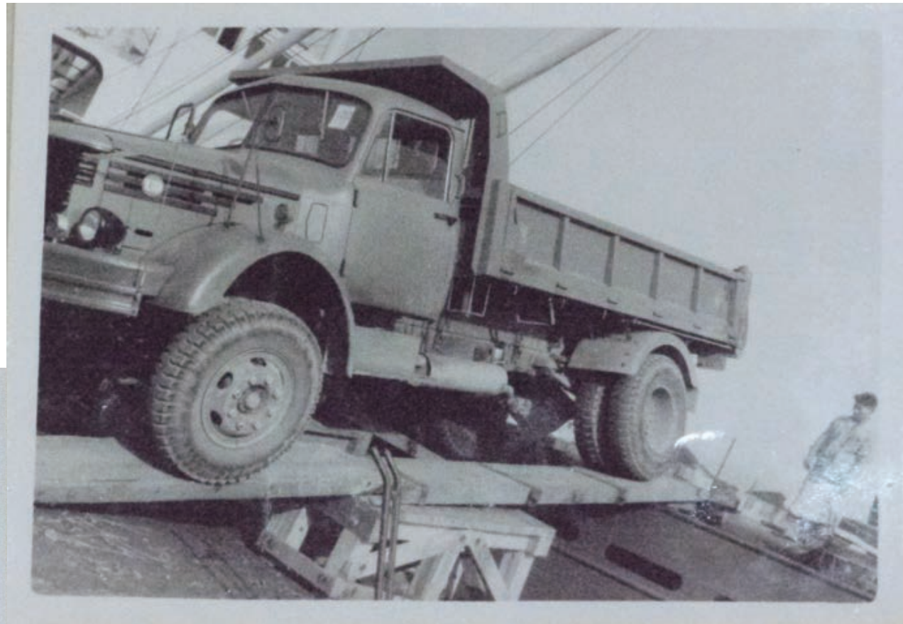
函館港につき、船から車両をおろす際、トラックの後輪が足場を踏み外した。修復するのに時間がかかり、下船が遅れた
